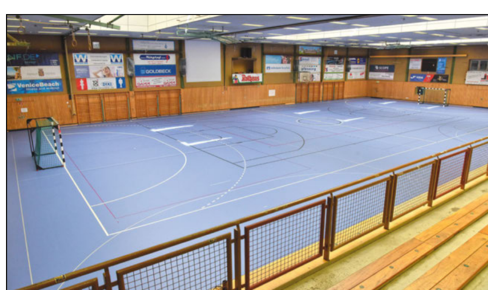
Die Sanierung der Heinrich-Beck-Halle startet im April; im August ist der neue blaue Hallenboden fertig. Während der nächsten zwei Jahre wird die Halle weiter saniert. Foto: Dorn
